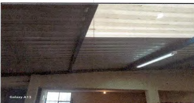
Foto 6: Cambio de cableado eléctrico y focos en el módulo de cocina
