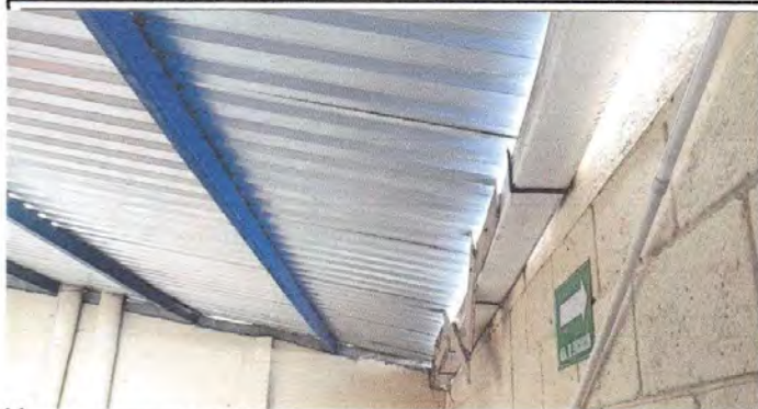
Foto1: sustitución de techo en el módulo de cocina
