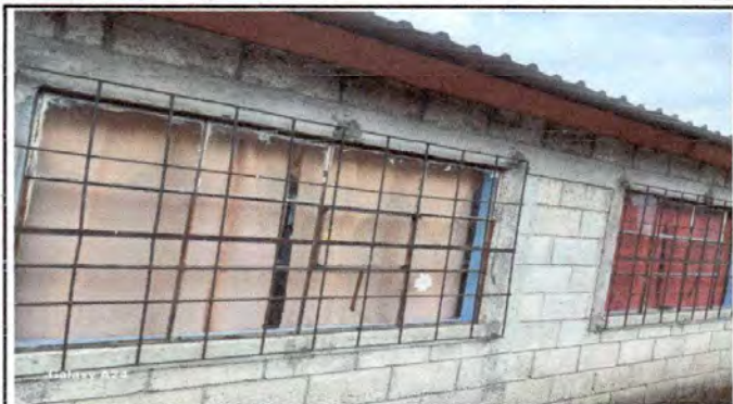
Foto1: Sustitución de balcones en módulo de salón
