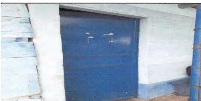
Foto 5: Mantenimiento de puerta lijado y pintado en el módulo de dirección
