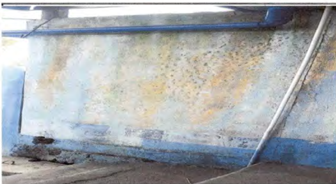
Foto 3: Pintura en exterior e interior en módulo de salón
