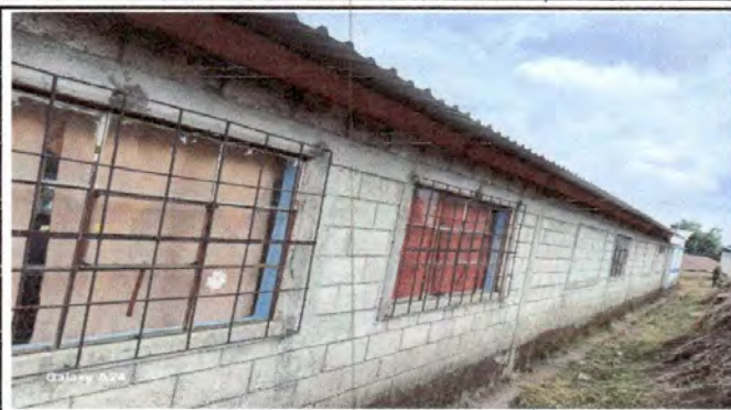
Foto 2: Repello en exterior en módulo de salón
