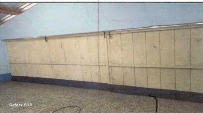
Foto 4: Pulido de piso en módulo de salón
