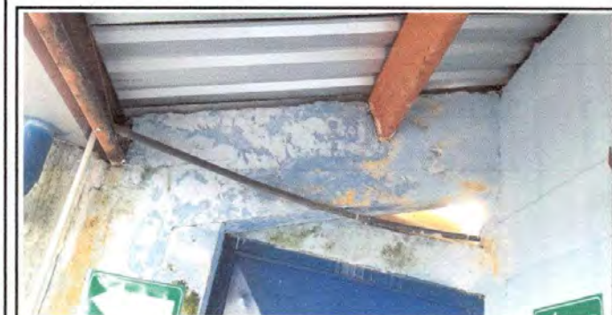
Foto 5: Pintura y cambio de cablead eléctrico en el módulo de cocina
