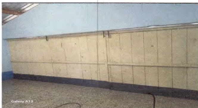
Foto 4: Pulido de piso en módulo de salón
