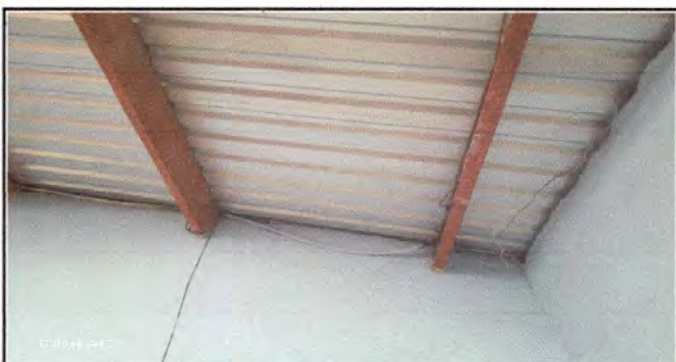
Foto 3: cambio de cableado eléctrico en el módulo de dirección
