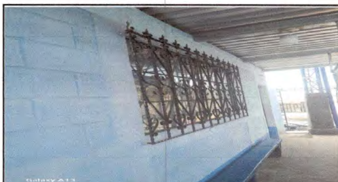
Foto 4: Mantenimiento de balcones lijado y pintado en el módulo de dirección
