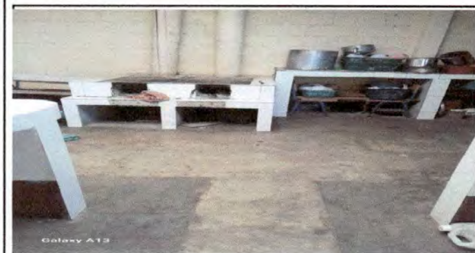
Foto 3: sustitución de piso en el módulo de cocina
