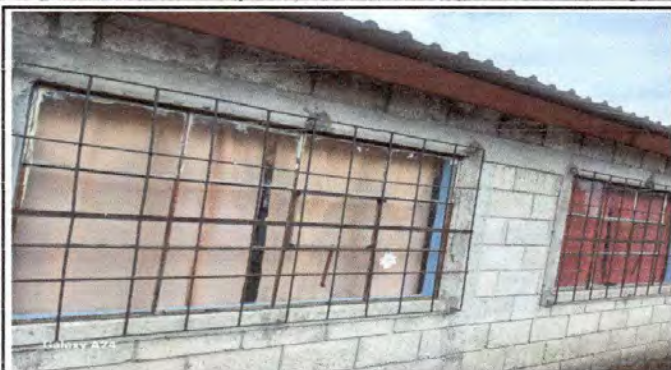
Foto 1: Sustitución de balcones en módulo de salón
