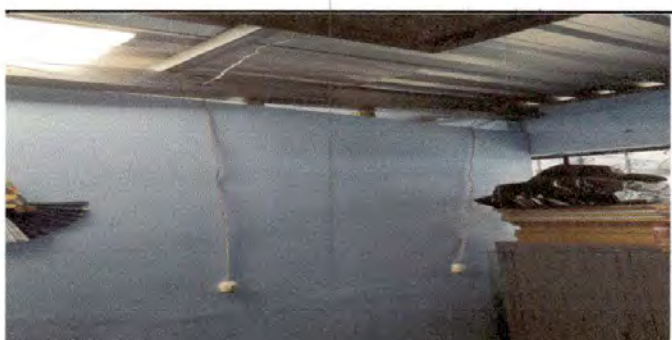
Foto 6: Cambio de interruptores y tomacorrientes en el módulo de dierección
